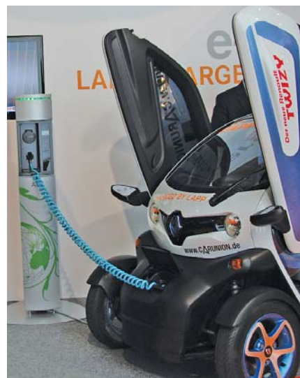
Rys. 9. Stacja ładowania pojazdów elektrycznych wykorzystująca przewody Lapp
