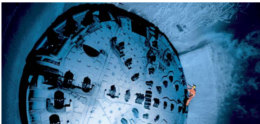
Rys. 1. Głowica maszyny drążącej o średnicy 11,8 metra podczas pracy w najdłuższym tunelu kolejowym – alpejskim Gotthard Base Tunnel; w maszynie wykorzystano m.in. przewody zasilające i sterujące Ölflex oraz złącza Epic firmy Lapp Kabel
