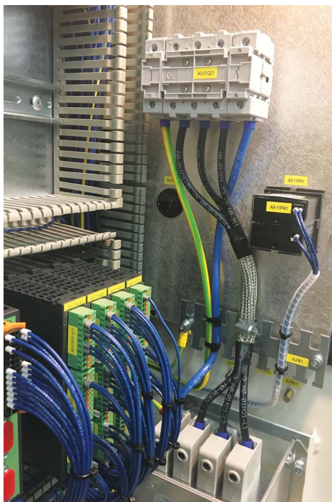
Rys. 2. Zamontowany oplot CU 1020
