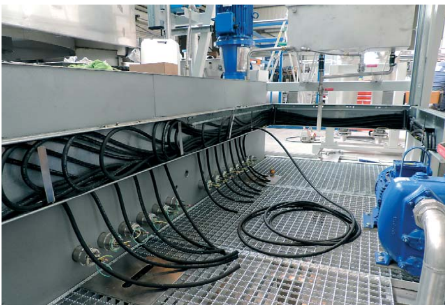
Rys. 2. Przewody Olflex Robust w trakcie rozprawiania
