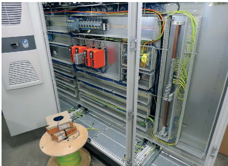
Rys. 6. Szafa sterownicza w trakcie montażu (pojedyncze linki Lapp Kabel)
