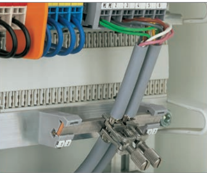
Obejmy zaciskowe do ekranu ze śrubą na miedzianej szynie zbiorczej na izolowanych wspornikach ④ ⑤ ⑥ ⑦ ⑭ ⑮ ⑯ ⑰ ⑱ ⑲ ⑳
