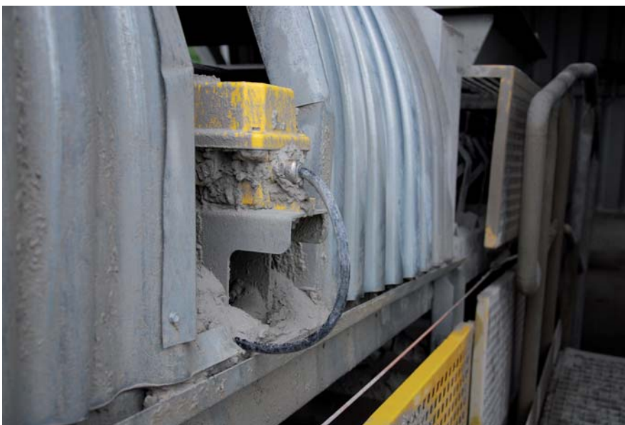
Rys. 2. Przewód Ölflex Classic 110 CY Black 0,6/1 kV oraz dławnica Skintop MS-M Brush – zastosowanie przy taśmociągu
