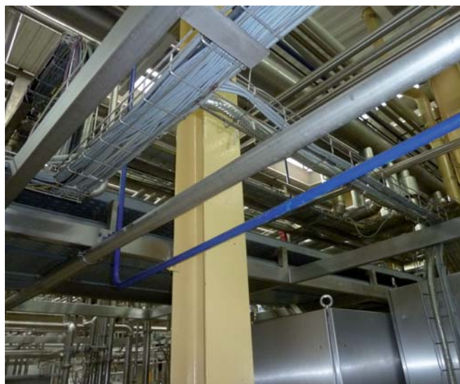
Rys. 3. Okablowanie w SM w Gostyniu zrealizowane przy wykorzystaniu przewodów Lapp Kabel
