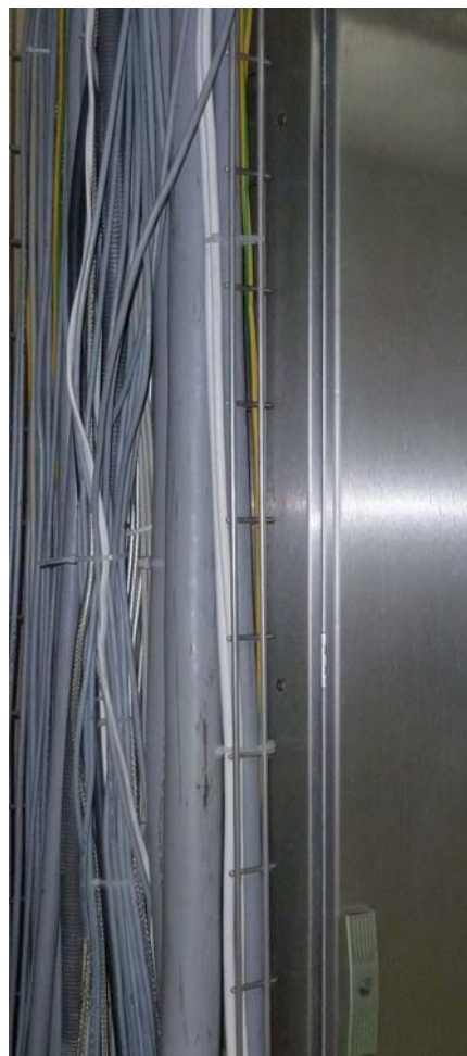
Rys. 2. Zasilanie i sterowanie z szafy urządzeń przygotowania surowca
