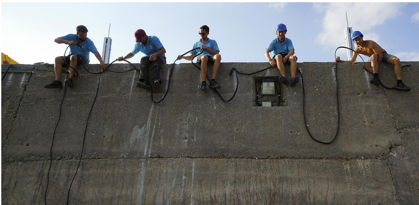
Rys. 3. Rozprowadzanie przewodów siłowych Lapp na nabrzeżu w Heraklionie
