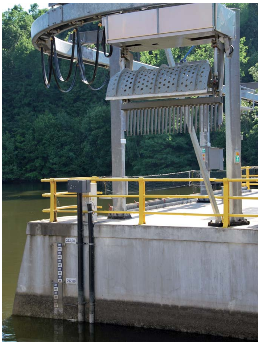
Rys. 4. Czyszczarka usuwająca większe zanieczyszczenia z wody dopływowej
