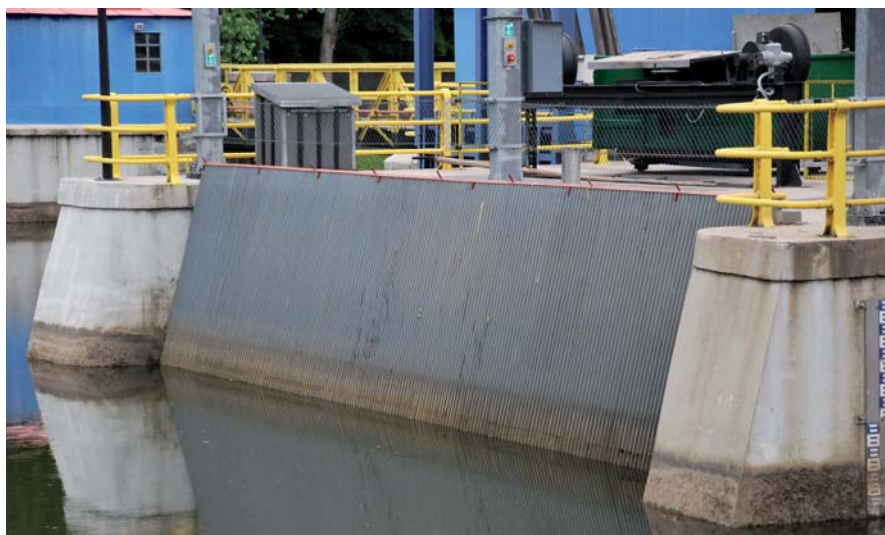
Rys. 3. Widok kanału doprowadzającego wodę do komór turbinowych
