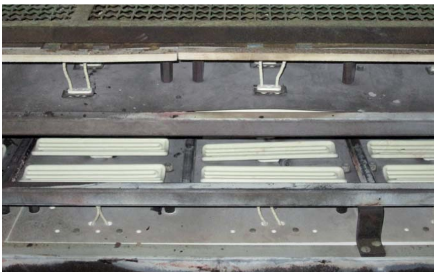
Rys. 3. Przewody Ölflex Heat 350 wykorzystane do zasilania promienników IR
