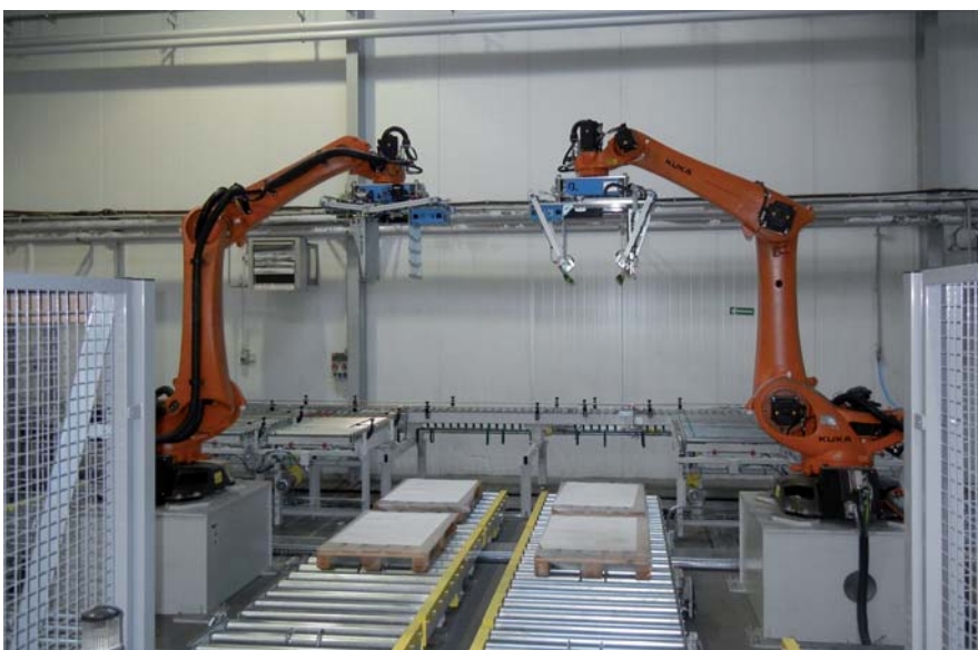
Rys. 1. Zrobotyzowana linia logistyczna do transportu opakowań w firmie Karton-Pak
