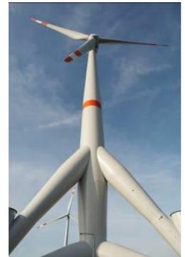
A turbina Multibrid M5000 são testadas no tempo e com ventos. Elas são fixadas a 30 metros de altura em uma estrutura de três pernas, as quais são ancoradas por estacas gigantes no fundo do mar. A partir do nível da água até a ponta da hélice, a unidade terá impressionantes 143 metros fora da água. Cada hélice do rotor mede 56,5 metros.
