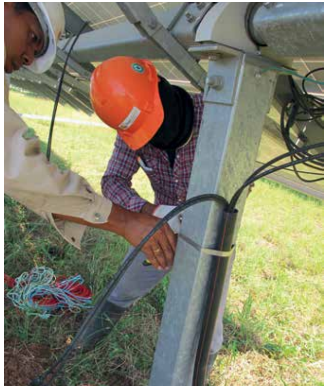
Ein Mitarbeiter installiert die wasserdichte Solarleitung.
