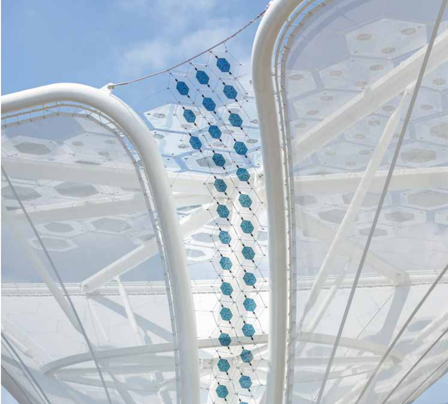
Organische Photovoltaik-Objekte im Deutschen Pavillon auf der Weltausstellung in Mailand
