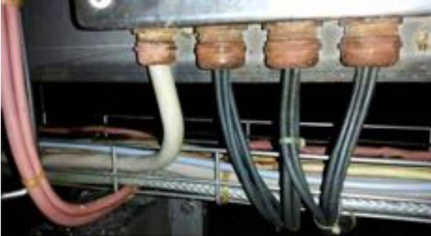
In der Lebensmittel- und Getränkeindustrie sind Kabel und Verkabelungskomponenten besonderen Belastungen ausgesetzt. Werden ungeeignete Komponenten verwendet, dann können Verschraubungen korrodieren und Kabelmäntel aufquellen, wie im Bild zu sehen. Die Komponenten verlieren teilweise ihre Funktion und es können gefährliche Situationen entstehen.
