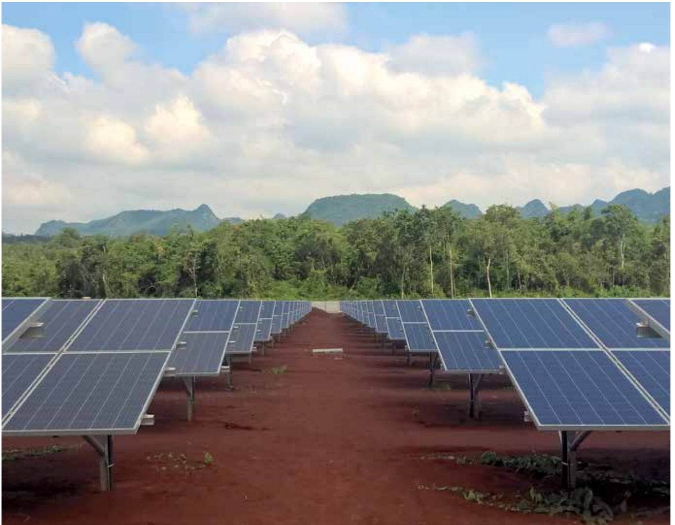
Die 18 MWp-Solaranlage in der Provinz Kanchanburi.
