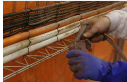
Hier wordt de bekabeling bevuild om vervolgens de reinigbaarheid te testen
