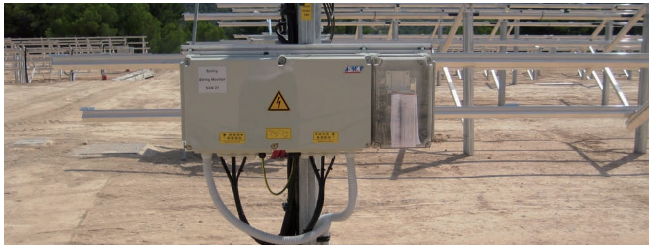
Convertisseur DC/AC (onduleur) avec câblage ÖLFLEX® SOLAR XLV
