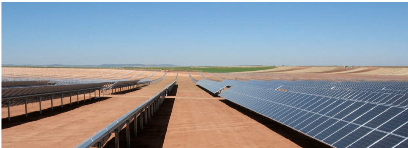
Solar park La Solana (Spanje)
