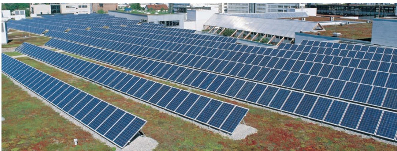
PV-systeem op het dak van het Lapp Group Logistics Centre (Stuttgart)
