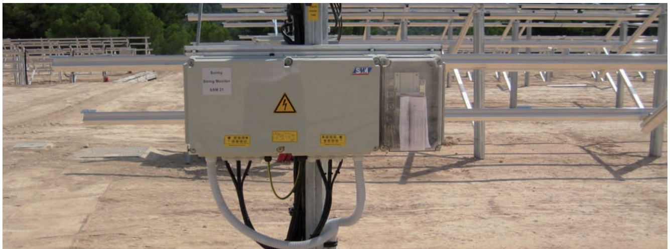
DC/AC omvormer met ÖLFLEX® SOLAR XLSv bekabeling
