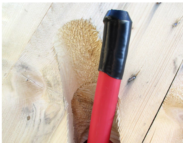
Ochrana konců kabelů proti vnější vlhkosti pomocí tepelně smrštitelných krytek
