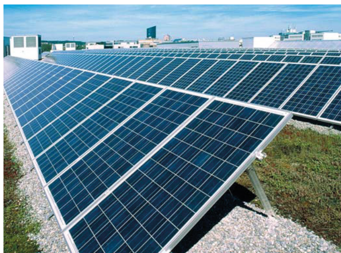
LAPP GROUP logistické centrum Ve Stuttgartu, Německo, 168 kWp
