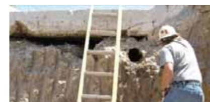
Obr. č. 4 – Dutina pod betonovým základem (zdroj: internet)
