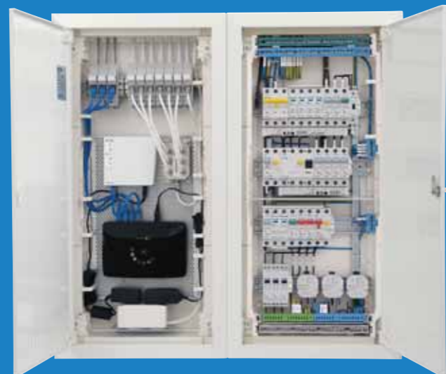
Příklad zapojení multimediálního a standardního provedení rozvodnice KLV
