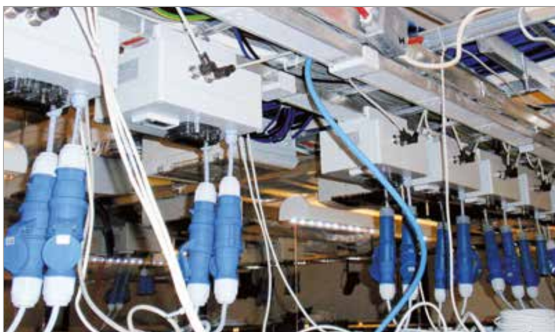
TJ-jakelukiskojärjestelmä integroidulla energianmittauksella
