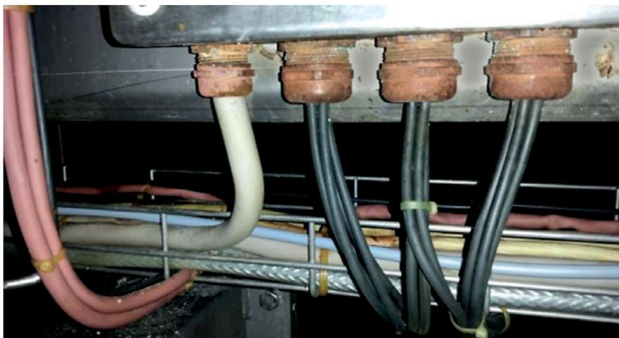
Dans l'industrie agroalimentaire et des boissons, les câbles et composants de câblage subissent des contraintes de charge. L'utilisation de composants inappropriés peut par exemple corroder le presse-étoupe et gonfler les gaines de câble, comme illustré dans l'image. Les composants perdent partiellement leurs propriétés et ceci peut entraîner des situations dangereuses.
