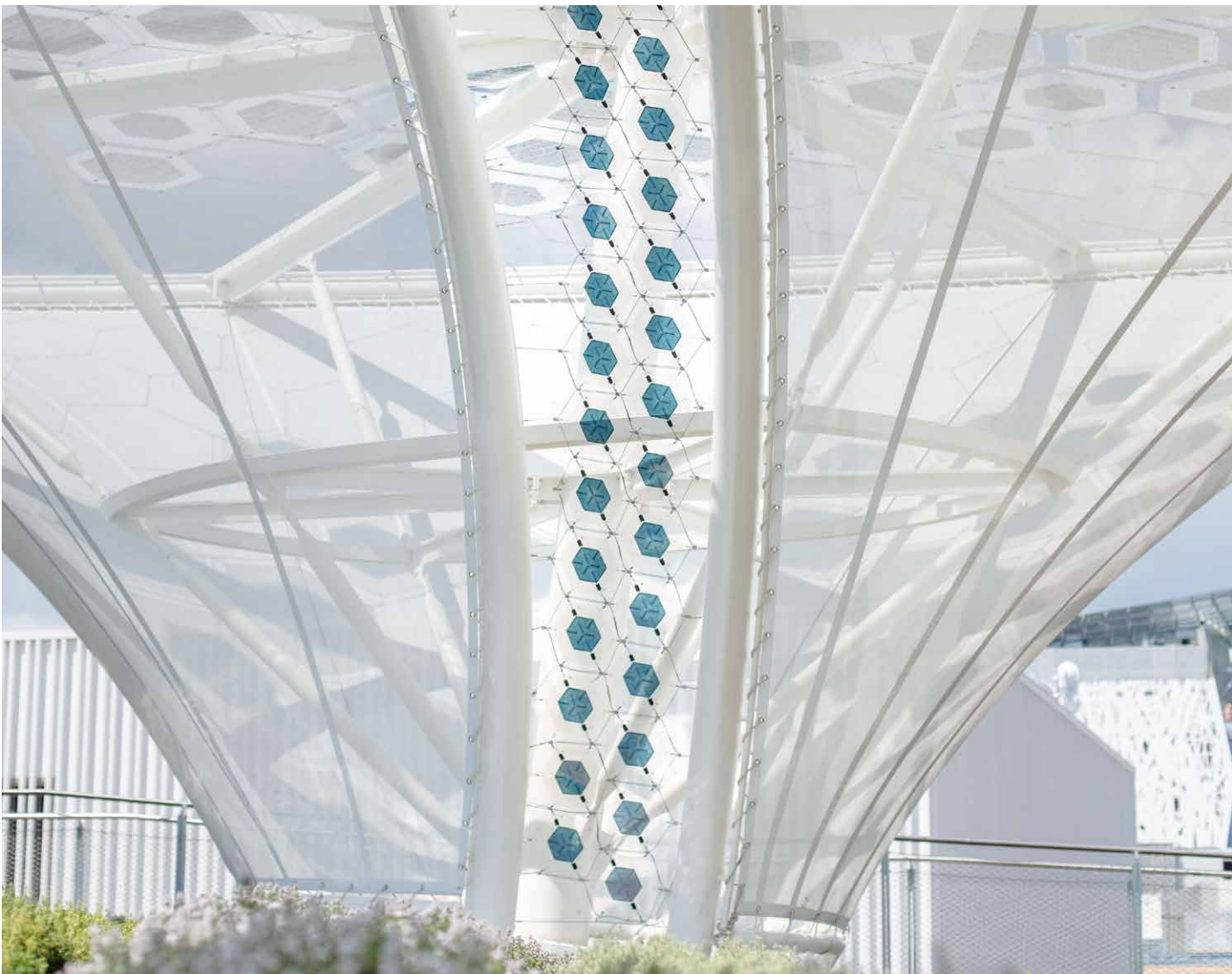
Organische Photovoltaik-Objekte im Deutschen Pavillon auf der Weltausstellung in Mailand
