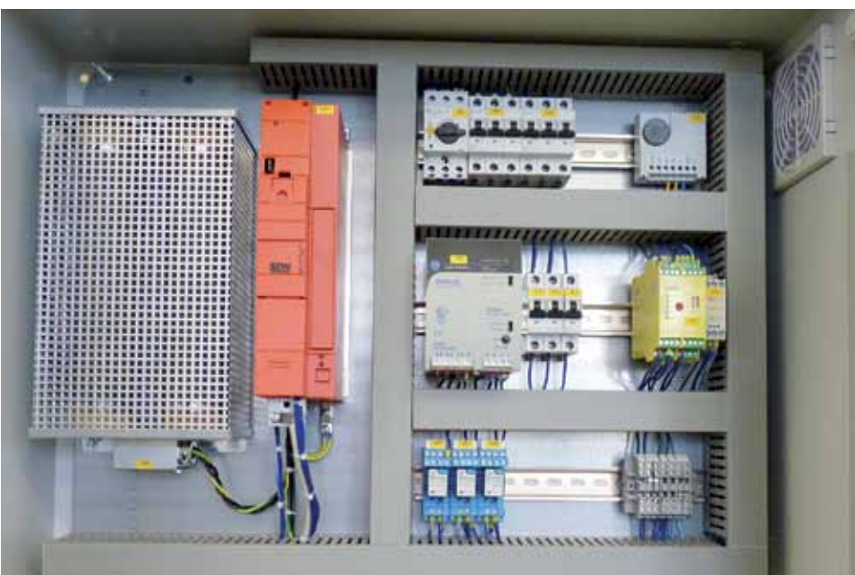
Подключение клемм, предохранителей и реле к преобразователю частоты переменного тока
