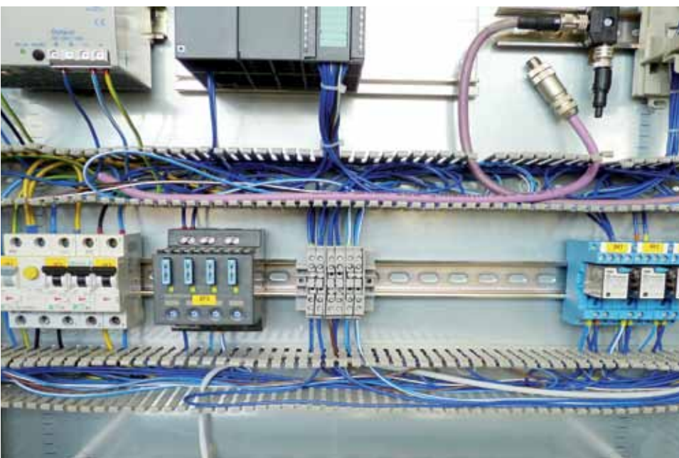
Подключение предохранителей, клемм и реле
