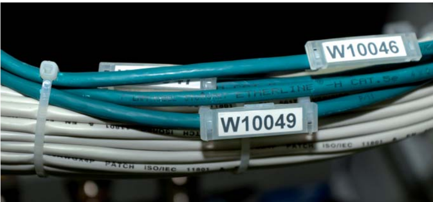
Rys. 4. Przewód Erherline – H CAT 5e w szafach sterowniczych Teatru Narodowego w Warszawie
