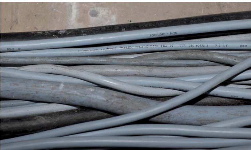
Rys. 3. Ölflex Classic 110 H zamontowany podczas modernizacji w 2010 roku – wiązka w pomieszczeniu sterowniczym
