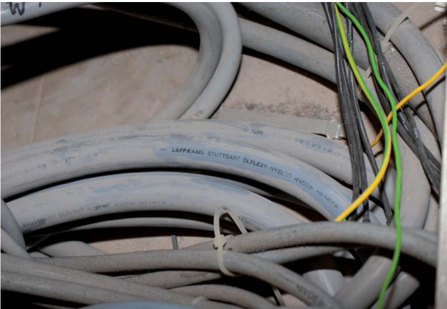
Rys. 2. Ölflex NYSLYO – sterowanie systemem hydraulicznym
