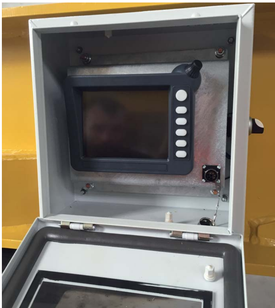
Rys. 5. Panel kontrolny HMI
