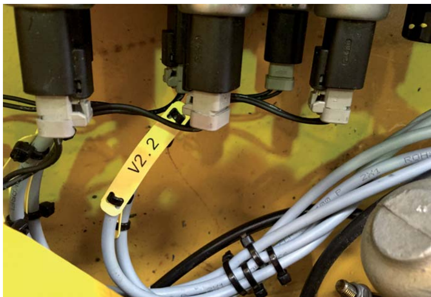
Rys. 2. Zasilanie cewek elektrozaworów wykonane przewodem Ölflex Classic 400P 2 x 1
