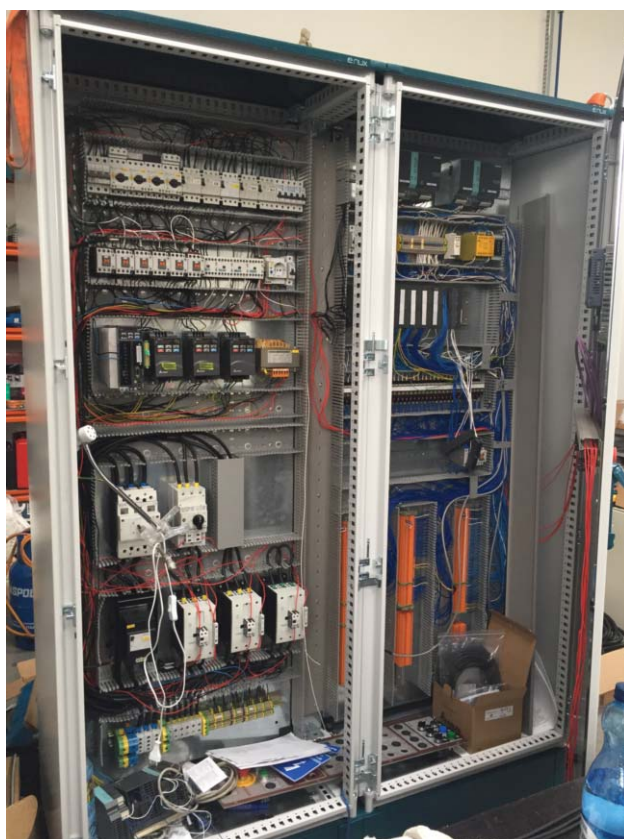
Rys. 1. Szafa sterownicza podczas montażu
