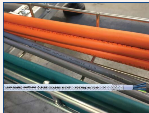
Rys. 3. Linia produkcyjna urządzeń do pomiaru gazów z przewodem Ölflex Classic 110 oraz ekranowana wersja tego przewodu: Ölflex Classic 110 CY
