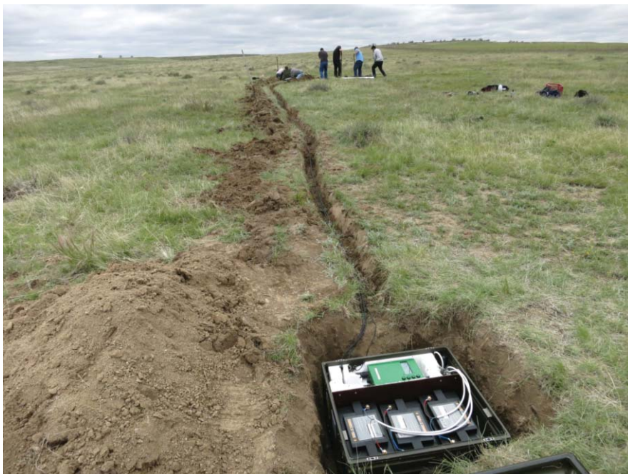
Rys. 5. Stacja Hugo systemu WERA – montaż urządzeń
