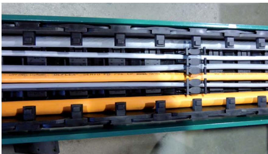
Rys. 2. Przewody Ölflex FD w prowadniku łańcuchowym maszyny WB2000
