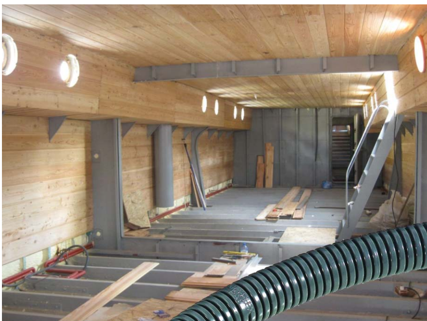
Rys. 2. Peszle Silvyn Rill Lapp Kabel wykorzystane do ochrony instalacji elektrycznej
