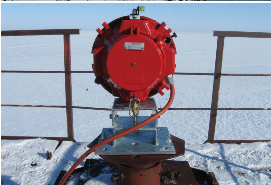
Rys. 1. W okablowaniu sygnałów i systemów nawigacji w Arktyce rosyjski firma Technomarine z siedzibą w St. Petersburgu opiera się wyłącznie na produktach firmy Lapp
