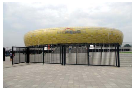
Rys. 3. Ogrodzenie stadionu PGE Arena w Gdańsku
