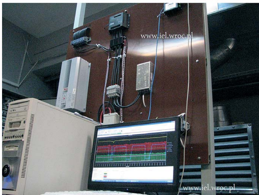
Rys. 3. Widok paneli fotowoltaicznych na dachu budynku oraz widok układu regulacyjnego
