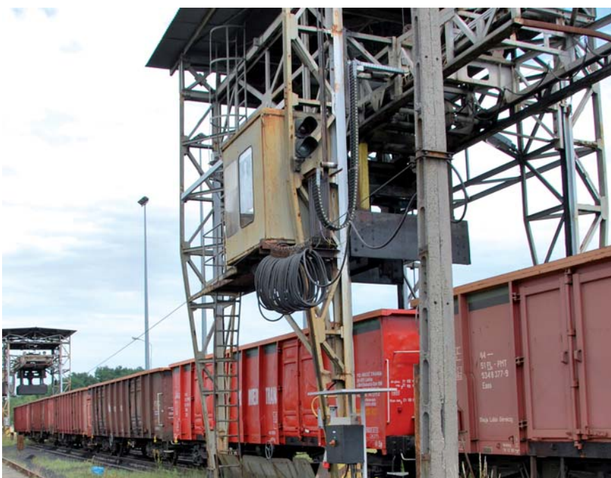
Rys. 1. Wyładownika wagonów przeznaczona do rozładunku węgla
