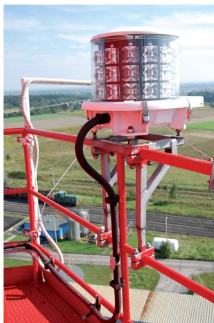
Rys. 10. Komin WPEC w Legnicy (wysokość 140 metrów) oraz peszel Silvyn Rill PA 6 zabezpieczający instalację zasilającą lampy przeszkodowej
