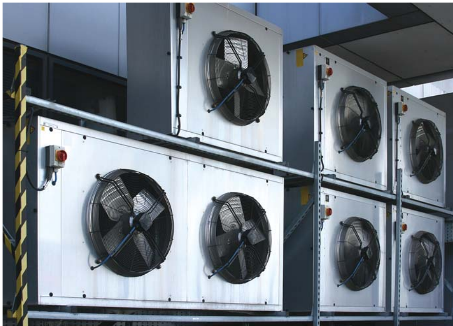
Rys. 5. Zasilanie wentylatorów z przemienników częstotliwości wymaga stosowania przewodów ograniczających emisję zakłóceń elektromagnetycznych
