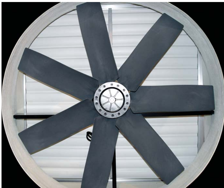
Rys. 1. Duże silniki wentylatorów nadmuchowych lub wyciągowych w układach centralnych wymagają zastosowania przewodów zasilających o odpowiednich przekrojach
