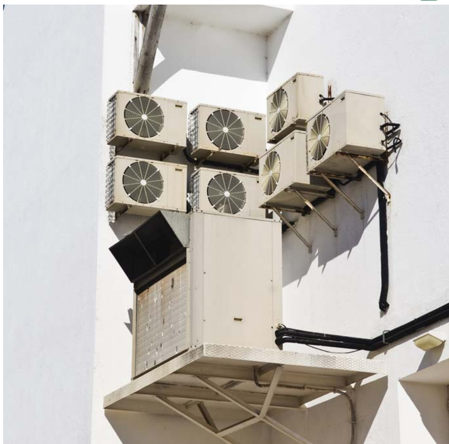
Rys. 2. Na zewnątrz konieczne jest stosowanie przewodów odpornych na promieniowanie UV lub zabezpieczenie połączeń odpowiednimi węzłami osłonowymi
