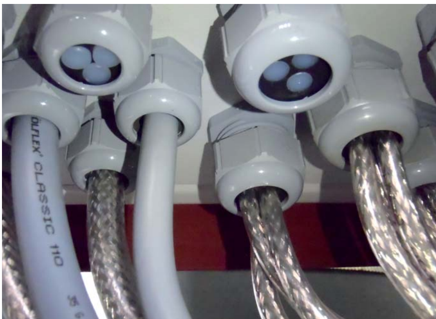
Rys. 7. Dławnice i akcesoria Skintop. Przykład aplikacji: szafka krosowa warnika cukrzycy
