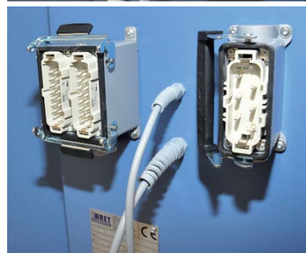
Rys. 4. Złącza: a – Epic H-BE 16, b – HB-S 6
