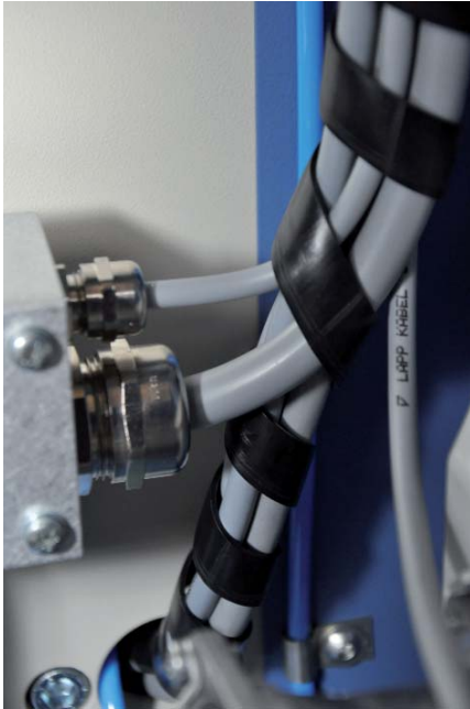
Rys. 6. Przewody Lapp Kabel zgodne z wymogami CE posiadające aprobaty UL oraz CSA na rynek europejski i północnoamerykański (od góry): Unitronic LiYY, Unitronic LiCY, Unitronic LiCY (TP), Ölflex 191, dwa specjalne przewody Enkoderowe i Resolverowe, przewód Multi-Standard
