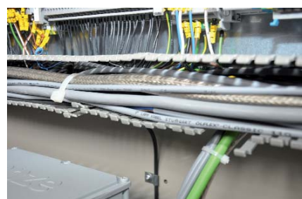
Rys. 3. Przewody serii Ölflex Classic oraz linki H07V-K prowadzone w korytach grzebieniowych
