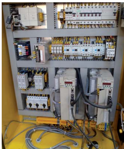
Rys. 3. Połączenia w obrębie szaf sterowniczych realizowane są poprzez linki H07V-K
