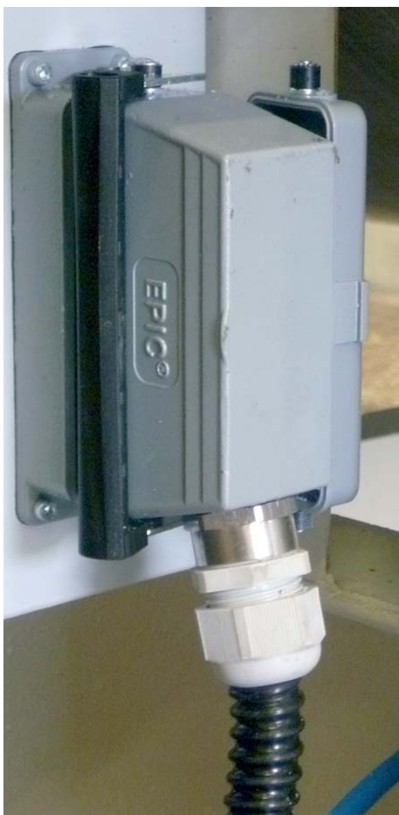
Rys. 5. Połączenie wykonane za pomocą złącza Epic
