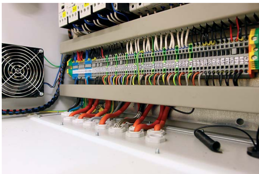
Rys. 3. Połączenia wewnątrz szafki sterowniczej wykonano za pomocą przewodów H07V-K
