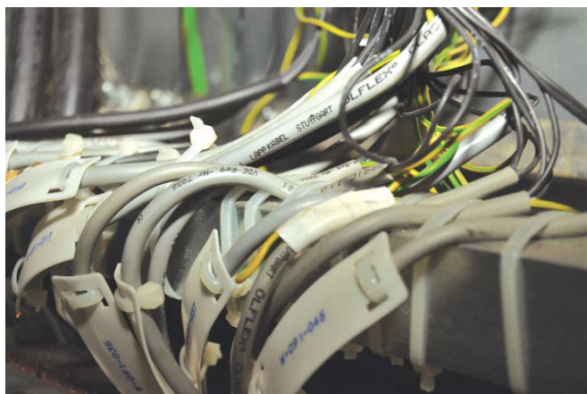
Rys. 9. Przewody Ölflex Classic zainstalowane w suszarni
