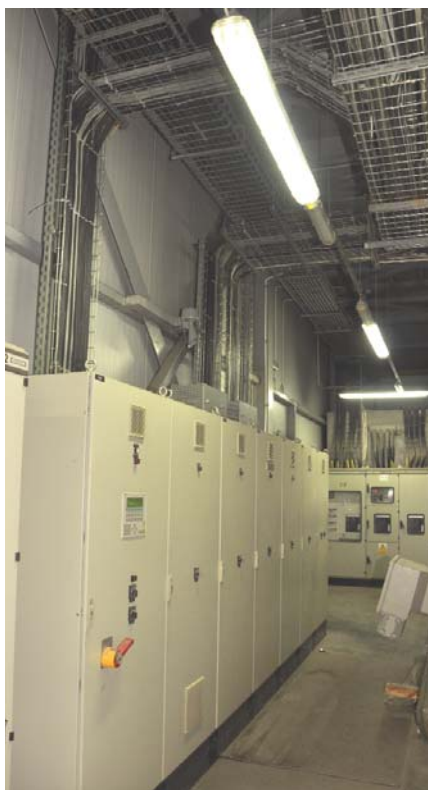
Rys. 6. Rozdzielnia w suszarni. Do połączeń z szafami sterowania wykorzystano m.in. przewód Unitronic do systemów Profibus
