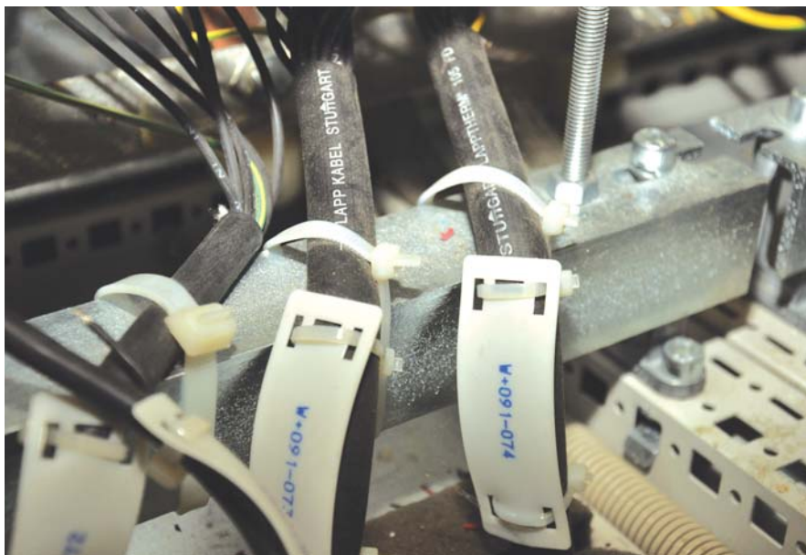
Rys. 8. Przewody Ölflex Lapptherm 105 w suszarni
