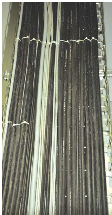
Rys. 7. Drabinki kablowe w suszarni
