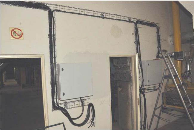
Rys. 2. Montaż przewodów Ölflex Classic Black do zasilania i sterowania zasuwami
