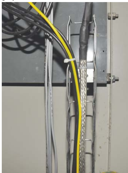
Rys. 1. Przewód Ölflex Servo 2YSLCY-JB – do zasilania odbiorników poprzez przemienniki częstotliwości
