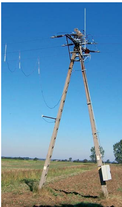
Rys. 4. Zdalnie sterowany rozłącznik słupowy
