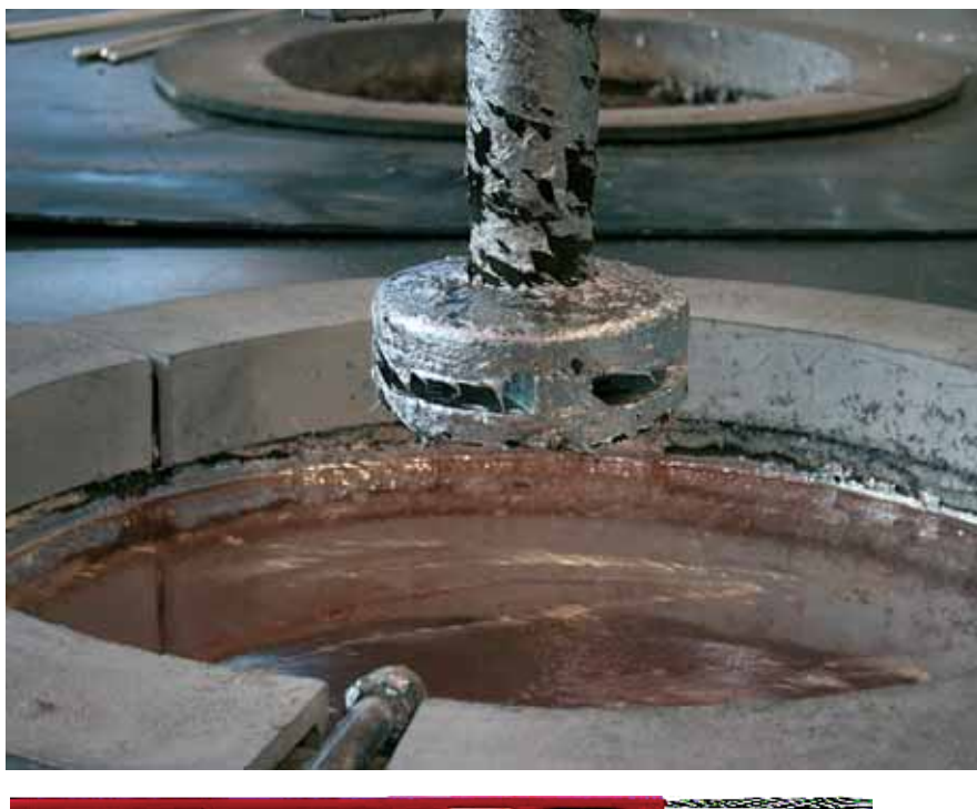
Rys. 1. Do zasilania termosów z płynnym aluminium wykorzystano przewody Ölflex Heat 180 SiF
