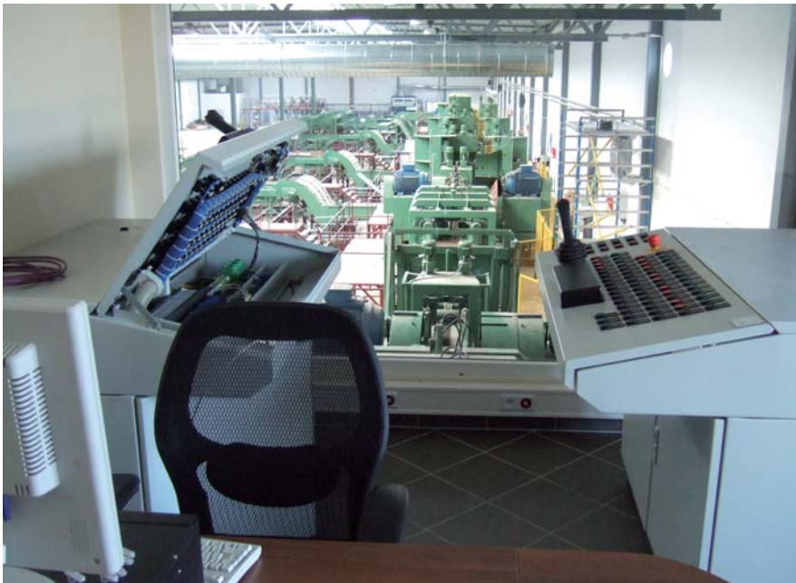
Rys. 1. Linia obróbki drewna w trakcie montażu – widok ze sterowni
