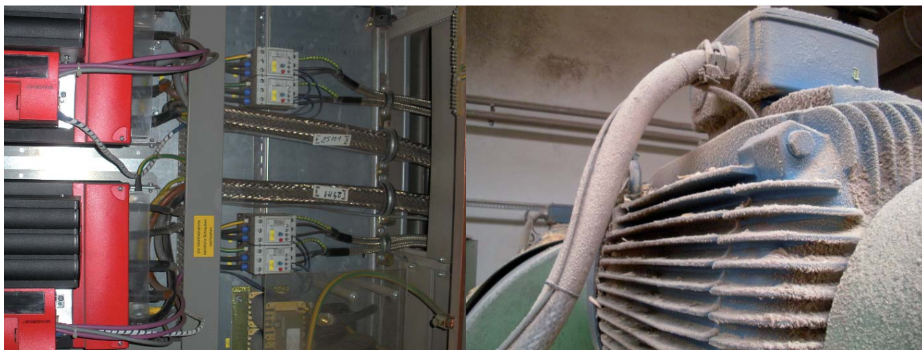
Rys. 5. Przewody zasilające 90-kilowatowy silnik rębaka z falownika i silnik podczas eksploatacji
