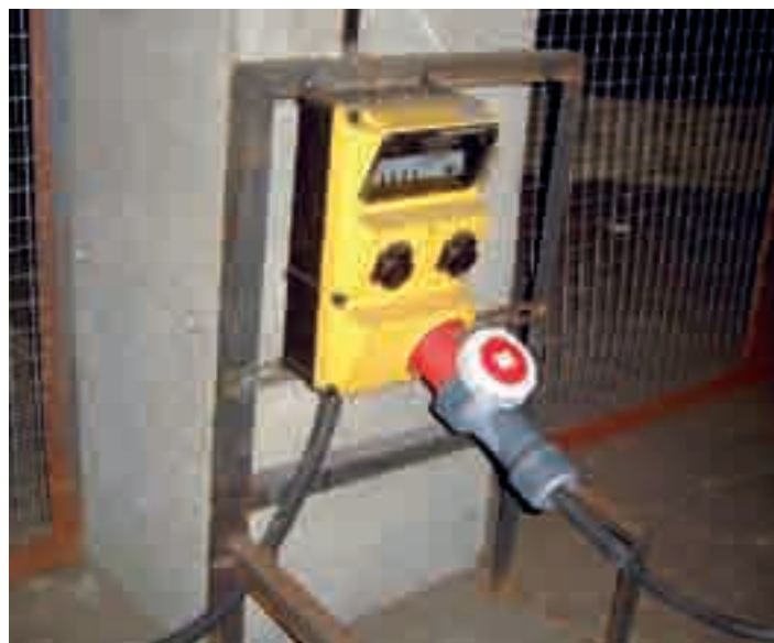
Казанский метрополитен, перегонный тоннель / Россия
