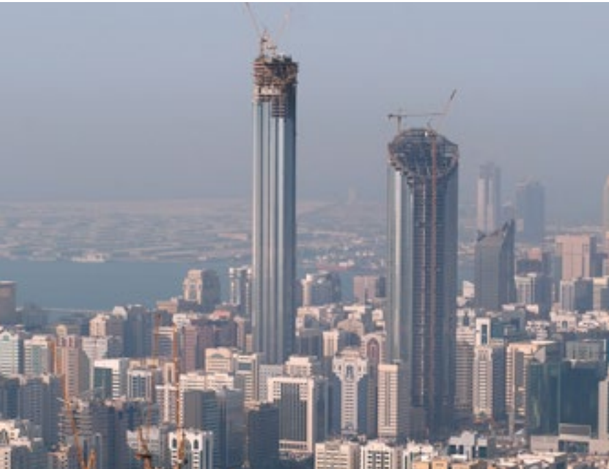
Проект Central Market на стадии строительства, Источник - Lapp Group
