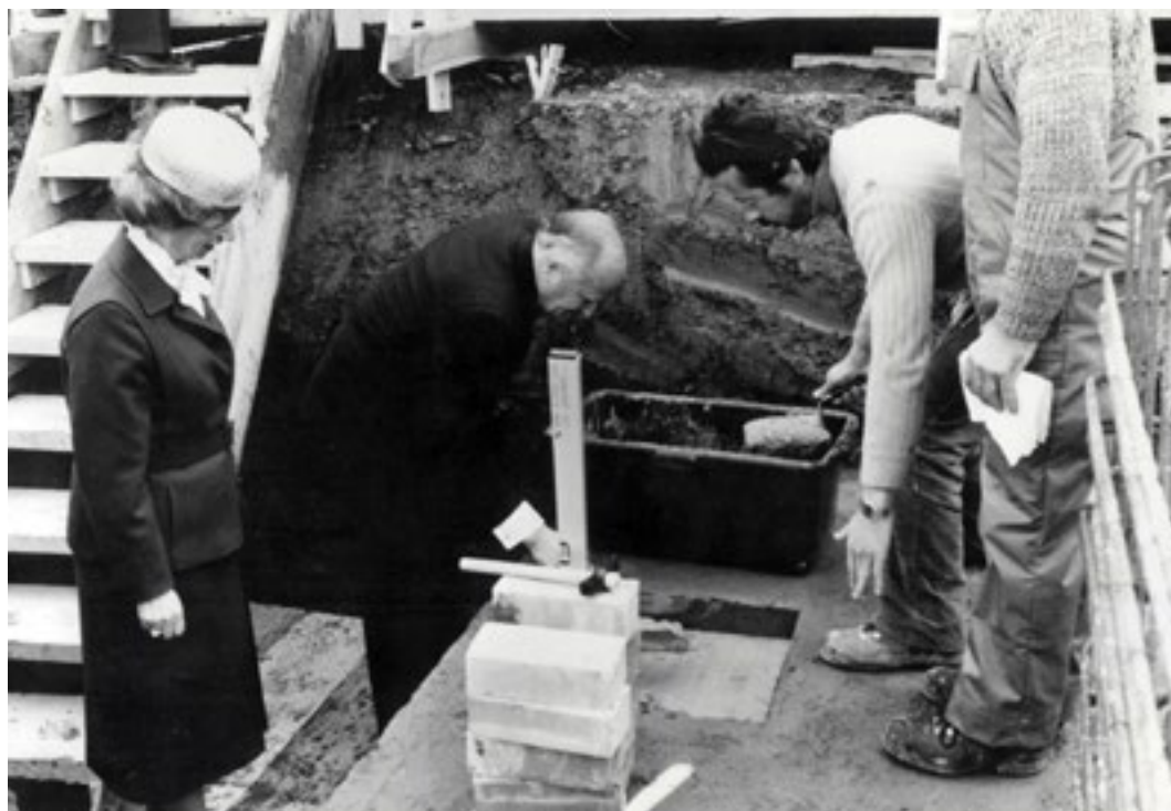
Урсула Ида и Оскар Лапп закладывают первый камень в фундамент здания кабельного завода, Источник - Lapp Group
