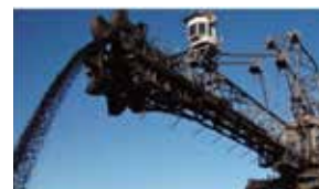
Grus- og pukkverk
